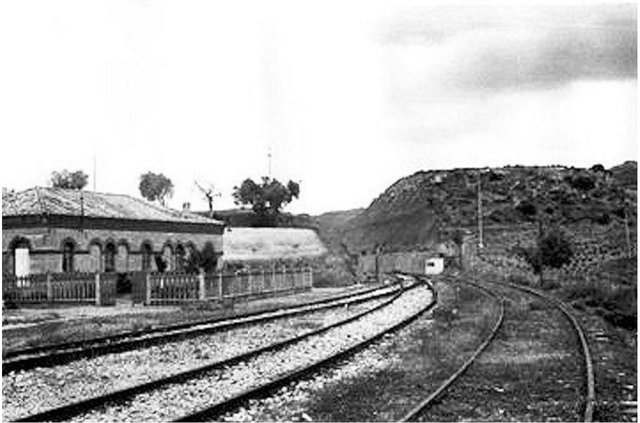
Vista de l'edifici objecte d'actuació
