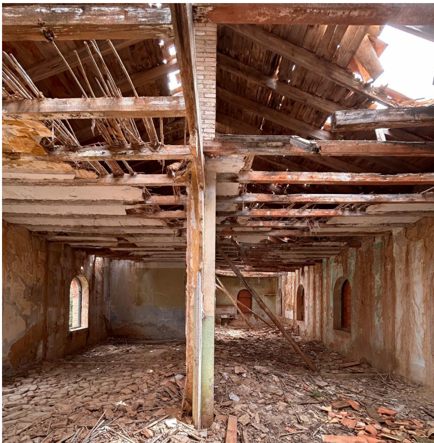
Estat general interior
